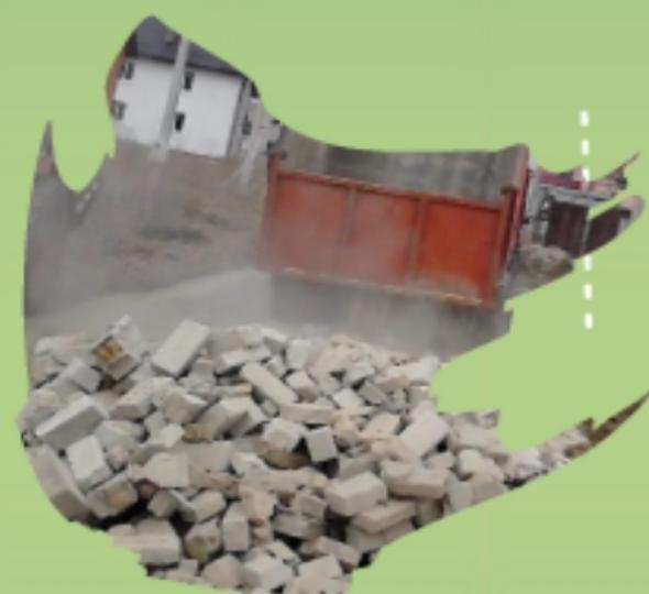
Дополнительный наполнитель Габионного каркаса
