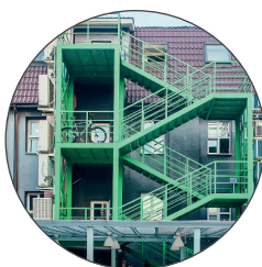
Окраска металлоконструкций в контрастные цвета
