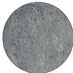
Бетон в покрытии пола
