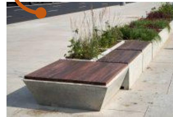
Малые архитектурный формы из переработанного бетона
