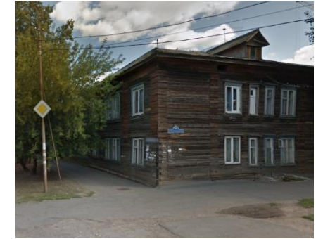
Здание, подлежащее сносу г. Тюмень, ул. ул. Интернациональная, д. 150
