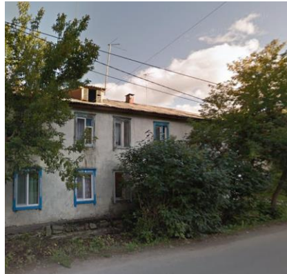
Здание, подлежащее сносу г. Тюмень, ул. Камчатская, д. 18 "а"
