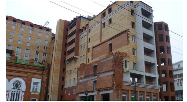
Здание, подлежащее сносу г. Тюмень, ул. Ленина, 31.
