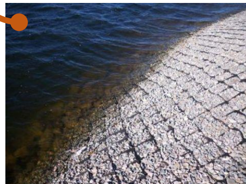
Пример применения переработанного бетона в качестве заполнителя георешетки
