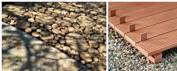
Временные пешеходные пути из спилов и деревянных тротуаров
