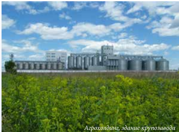
Агрохолдинг, здание крупозавода
